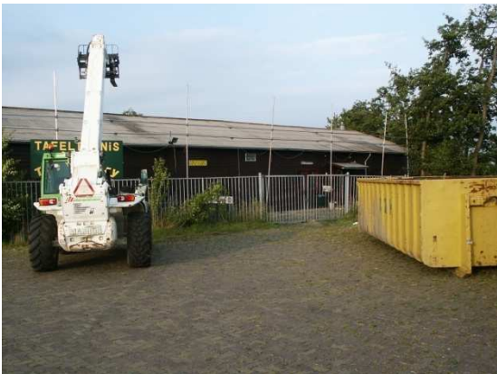
Het dak eraf! Asbestplaten netjes in gele containers.
